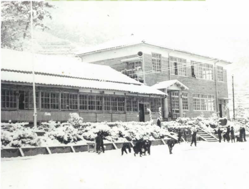
2階を増築した校舎（昭和26年～昭和34年）
