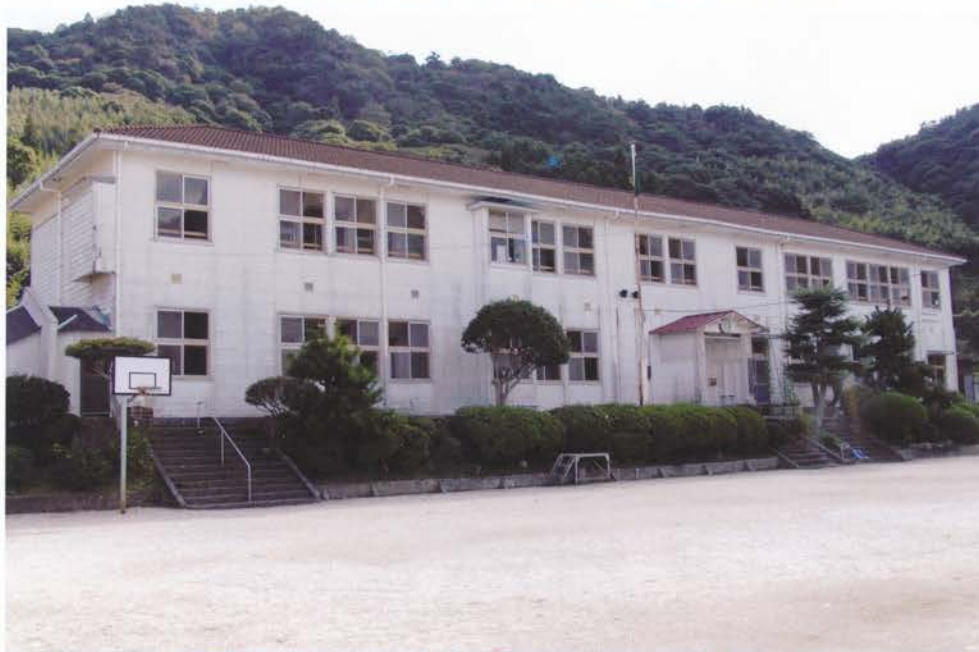
現在の校舎（昭和35年新校舎2階増築・給食室新築）
