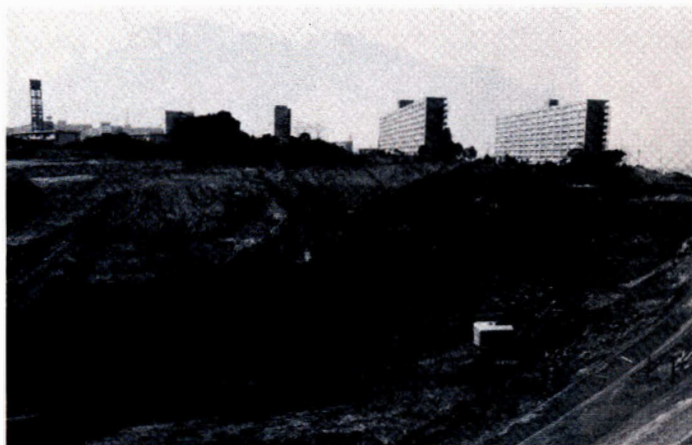
大和田—伽藍線工事(後方、大和田社宅)(昭和46年4月)
