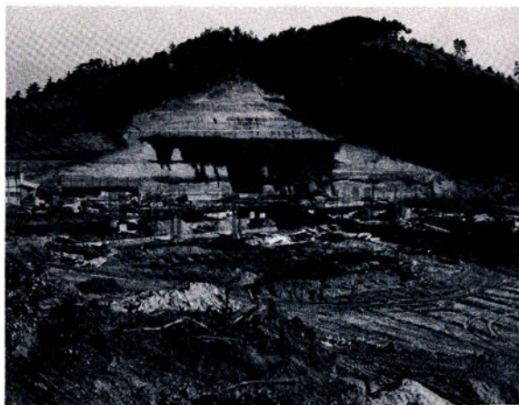
周西中学校本校舎基礎工事(昭和43年12月)
