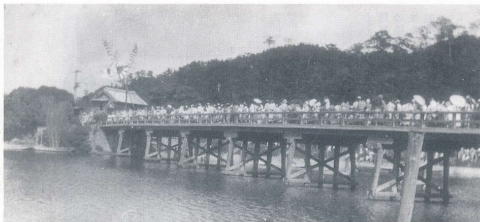
木造の人見橋、昭和26年に現在のコンクリート橋となる
