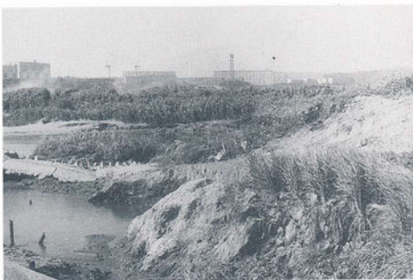
集中豪雨で決壊した堤防
