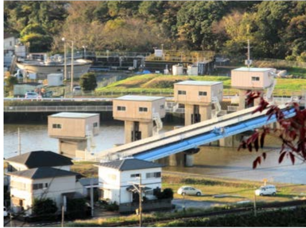
人見取水堰ゲート 千葉県企業庁 平成 25 年 4 月撮影
