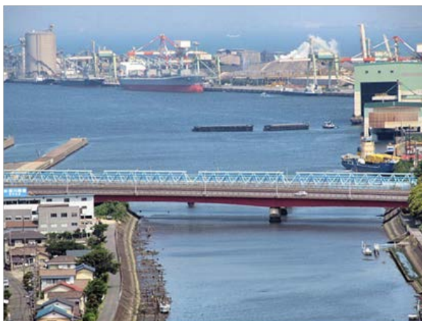
平成 25 年 君津大橋(空色の鉄骨は送水管)
