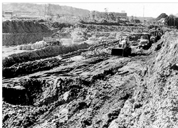
河川敷内改修工事状況
