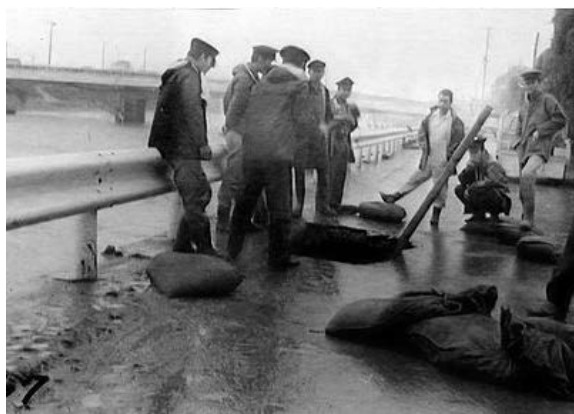
人見地先(町道1号幹線道路陥没・水道管切断)
