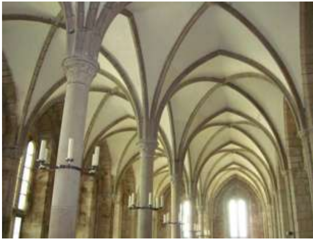
写真-3 貴賓室の柱と天井 (2011.8.8撮影)
