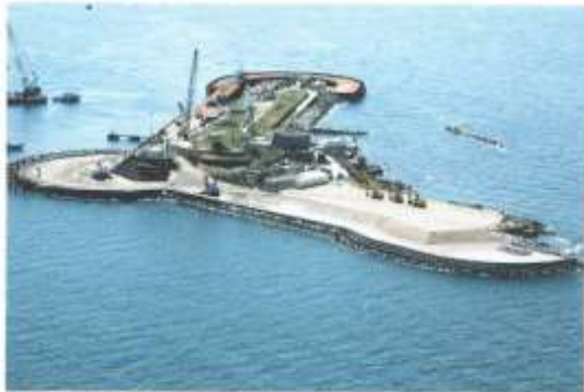
第二海堡の工事の様子 (2010. 6. 10 撮影) 朝日新聞 高山修一記者提供
