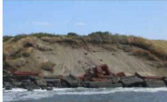
(写真-10) 東京湾第一海堡 南側 可也激しくコンクリート護岸壁が崩れ砂がむき出しの状態になっている。
