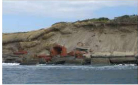
(写真-9) 東京湾第一海堡 南側護岸のコンクリート壁と上部にあった構造物の崩壊状況
