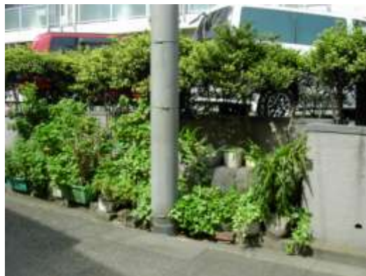
写真-11 渡り道の石垣
