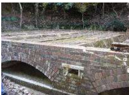
煉瓦で出来た基礎部
