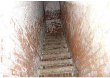
連絡通路より観測所へ上がる階段
