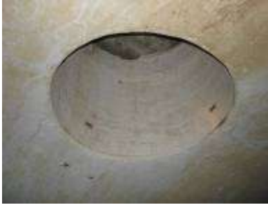
弾薬を地下弾薬庫から砲座へ上げる穴
