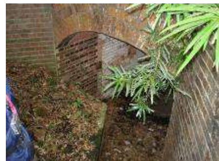
地下弾薬庫より第2砲座に出た所
