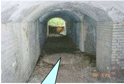
連絡通路及び弾薬搬送路
