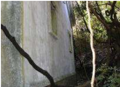
蔵の部分を残している箇所
