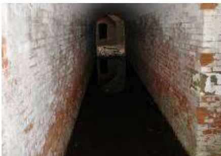
第四砲台第3砲座下通路 (正面に見えるのは、掩蔽部群)
