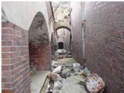
第二砲台 地下弾薬庫群
