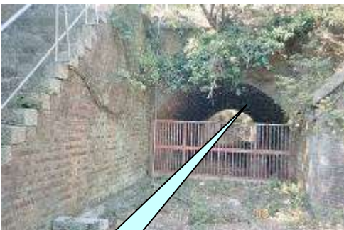
第2砲座下から第1砲座下へ 通じる通路
