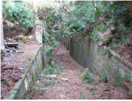
第四砲台兵舎・弾薬庫へ通じる道
