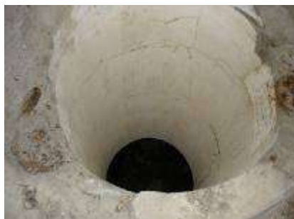
弾薬を地下弾薬庫より引上げる穴
