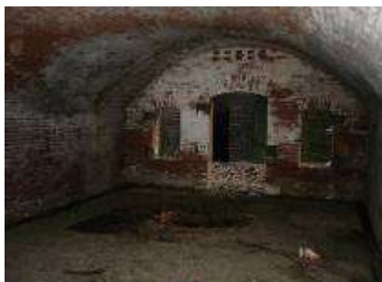
掩蔽部の中から外を見る
