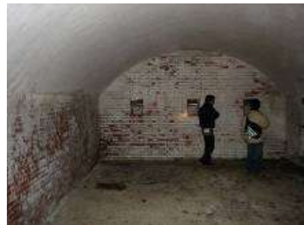
第四砲台第3砲座 弾薬庫
