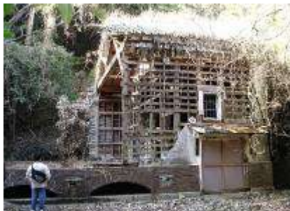
実際は殆ど崩れている
