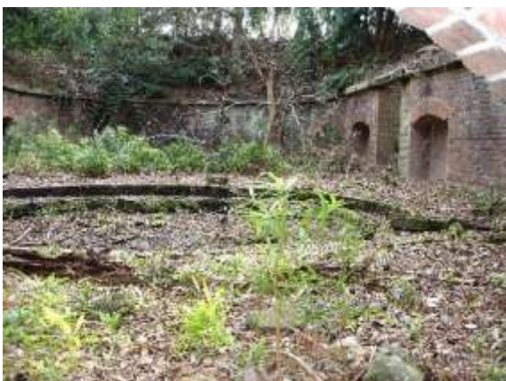
⑱これが砲台、砲座跡
