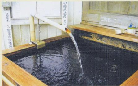
明治中期、上総地方で開発された。足場を設置し、地下300~700尺掘ると、きれいな水の水脈に達し、自噴する。街中に点在し、平成の名水100選に「生きた水・久留里」として指定された。
