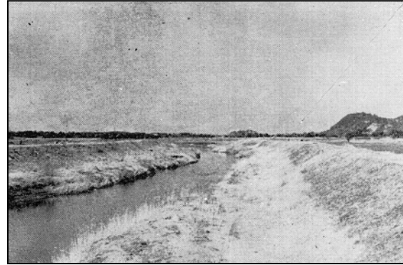
河川改修後の小糸川
