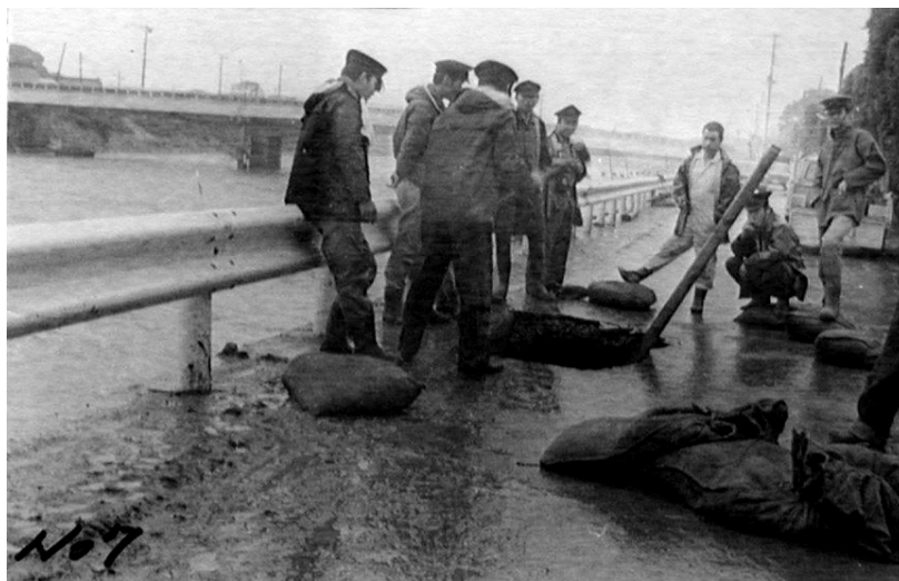
町道1号幹線人見地先 道路陥没・水道管切断
