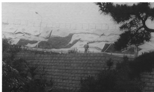
坂田地区・君津クラブ法面土砂流出
