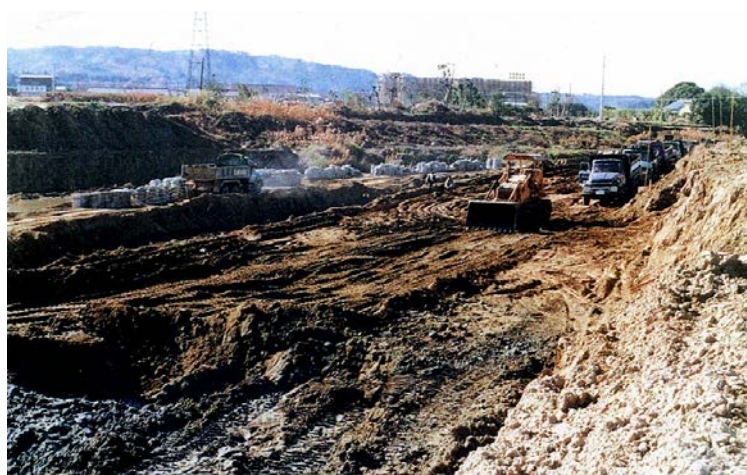
写真-11 河川改修工事
