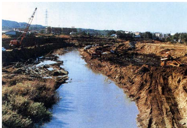
写真-8 河川改修工事風景 (中野付近)
