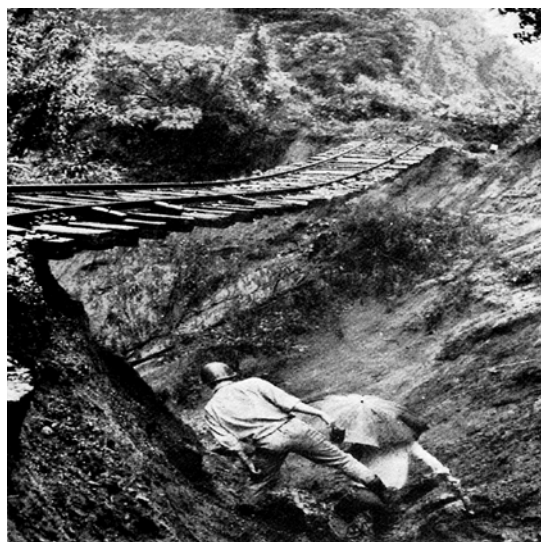
国鉄小湊駅の盛土流失(市原市折津付近)
