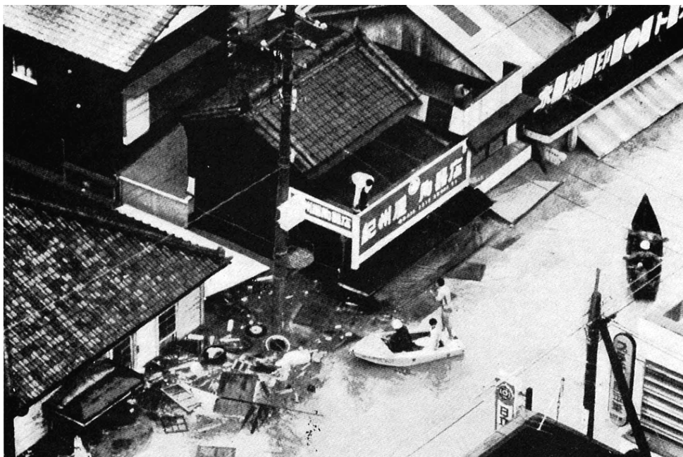
夷隅川の氾濫で屋根の底まで水につかった大多喜町の中心部
