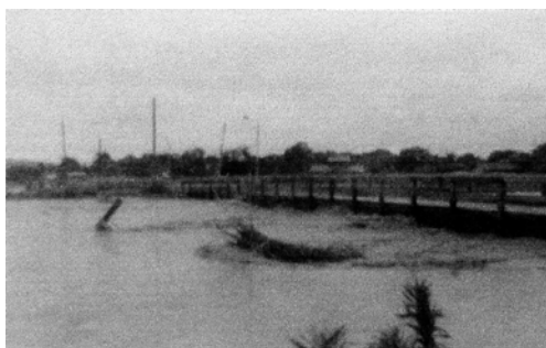
写真4 増水を続ける後生橋(流失)
