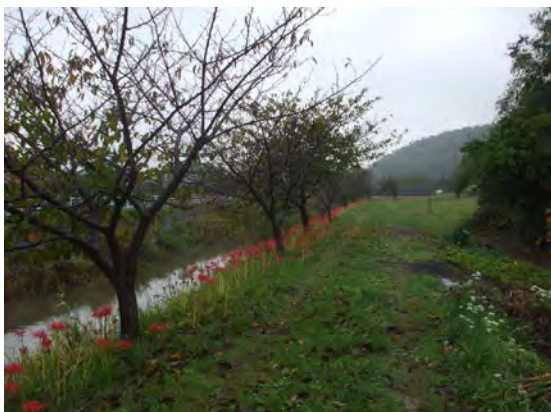
貞元橋から上流本道橋に向って右側
